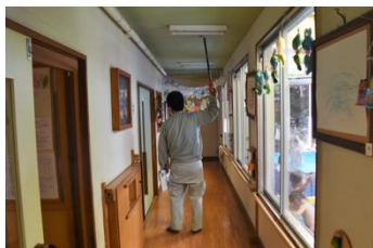
7/15 消防用設備点検 異常なしでした。
